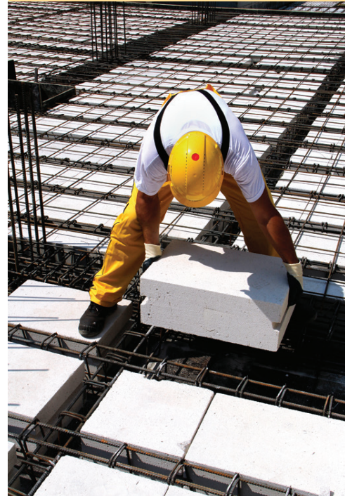
Kolayca kesilebilen Cepli Hafif Asmolen, uygulamada fire oluşturmuyor.
